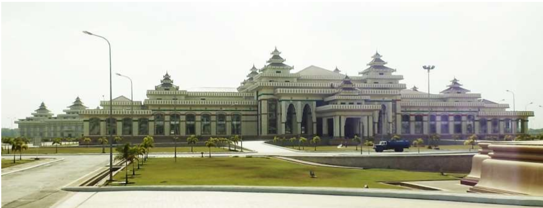
建物が余りにも多く、建物名不詳
